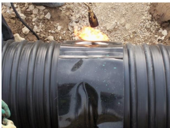
Рисунок 17. Процесс сварки газовой горелкой.
