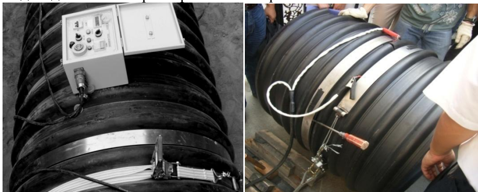
Рисунок 16. Процесс сварки электросварочным аппаратом
