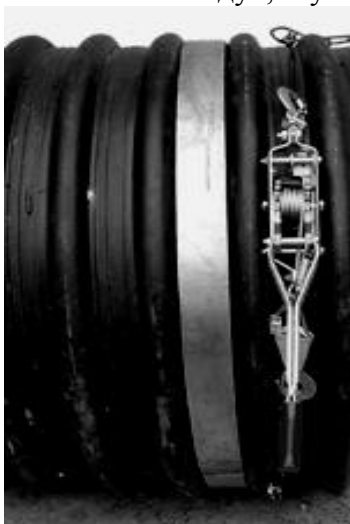
Рисунок 15. Стягивание лент при помощи лебедки.
