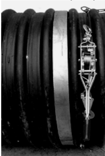
Рисунок 15. Стягивание лент при помощи лебедки.
