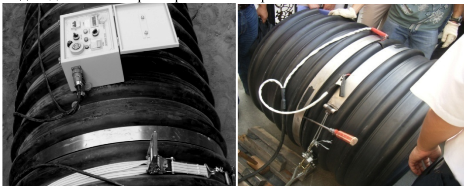
Рисунок 16. Процесс сварки электросварочным аппаратом
