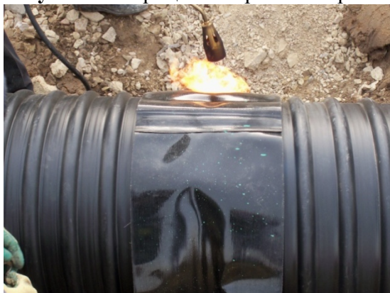
Рисунок 17. Процесс сварки газовой горелкой.
